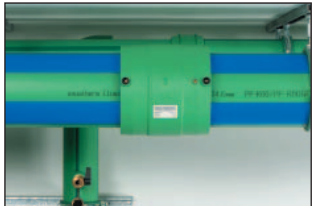
Het in de mof schuiven van de tweede, eveneens geschilde en gereinigde, buis.
